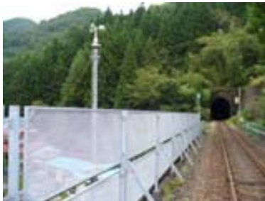
三杯式風速計と防風柵
