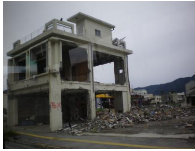
▲解体を示す赤マーク（釜石市）
