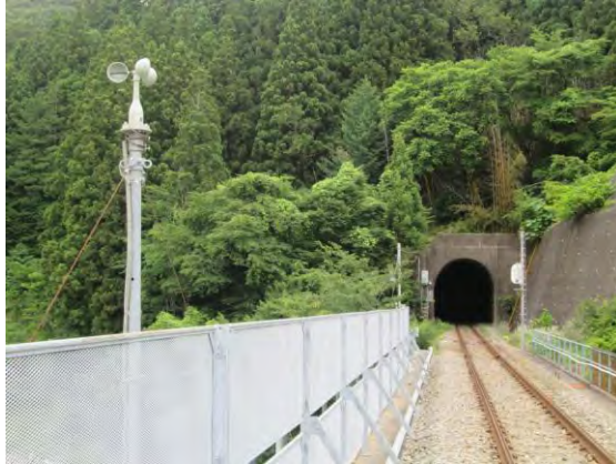
三杯式風速計と防風柵
