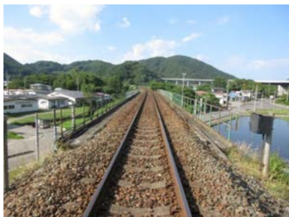
橋りょう高欄改修（前）
