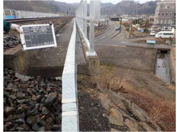
通信ケーブル更新（後）
