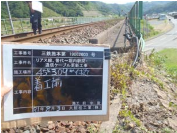
通信ケーブル更新（前）
