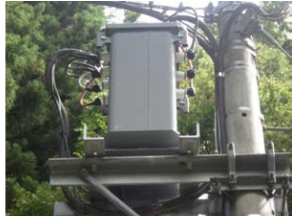
無線電源用変圧器更新（後）
