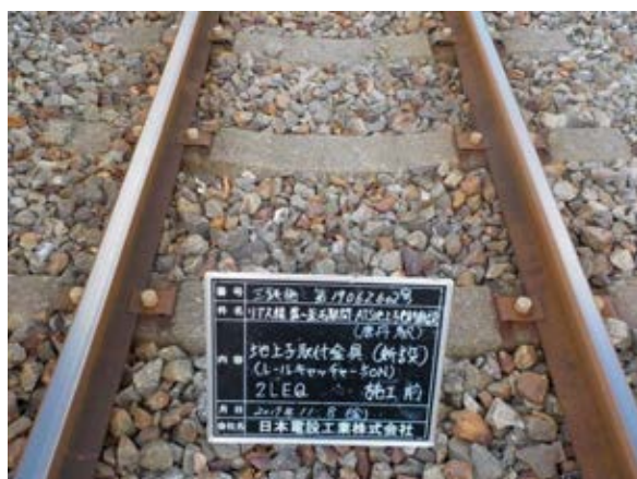
A T S更新・新設（前）
