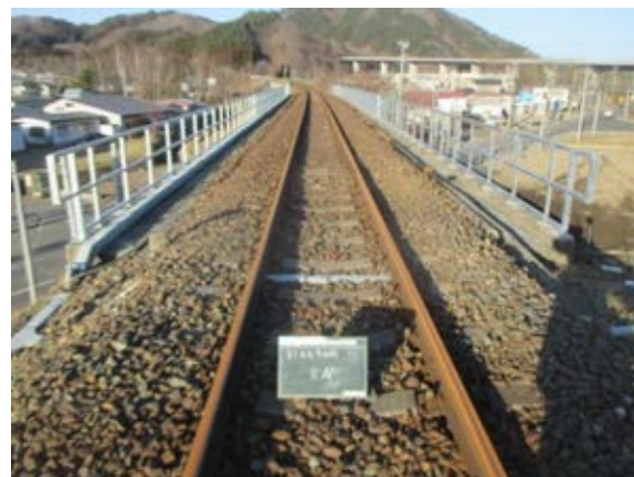
橋りょう高欄改修（後）
