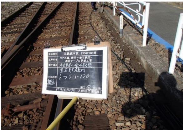
通信ケーブル更新（前）
