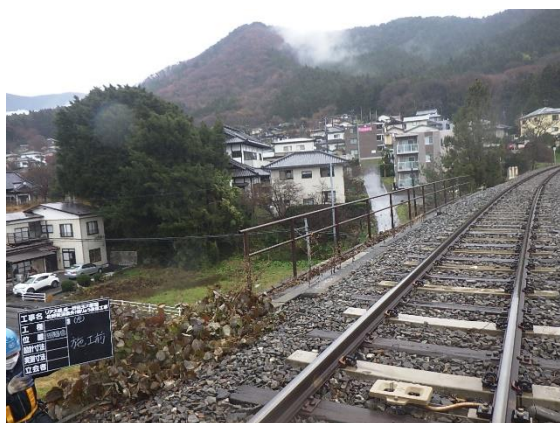
橋りょう高欄改修（前）
