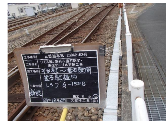
通信ケーブル更新（後）
