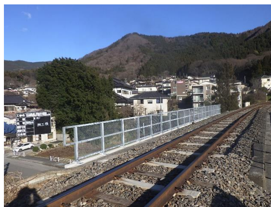
橋りょう高欄改修（後）
