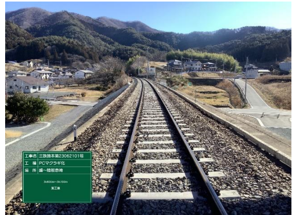
枕木交換（P C化）（後）
