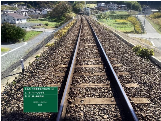
枕木交換（P C化）（前）
